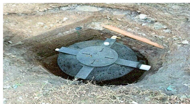
Foto 4: Imagen que nos muestra el lugar en donde se está instalando el biodigestor para optimizar la descarga de aguas negras al pozo de absorción.
