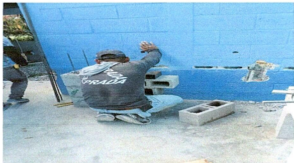
Foto 1: En esta imagen nos muestra el avance de los trabajos de instalación de diferentes accesorios para optimizar el uso de los servicios sanitarios.
